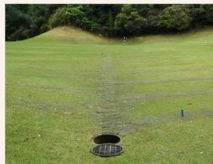
芝を切って排水管を設置し、溝に砂利をいれたあとに、剥いだ芝を張り戻す。作業に時間がかかるが、開渠と比べて排水効率は良い。
