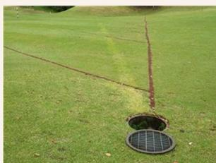
芝を切って排水管を設置し、溝に砂利をいれる方法。芝の張り戻し作業がないためスピーディーな対応が可能。短い期間で広い面積を改善するときに利用する。
