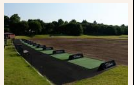
張り替え中の様子
